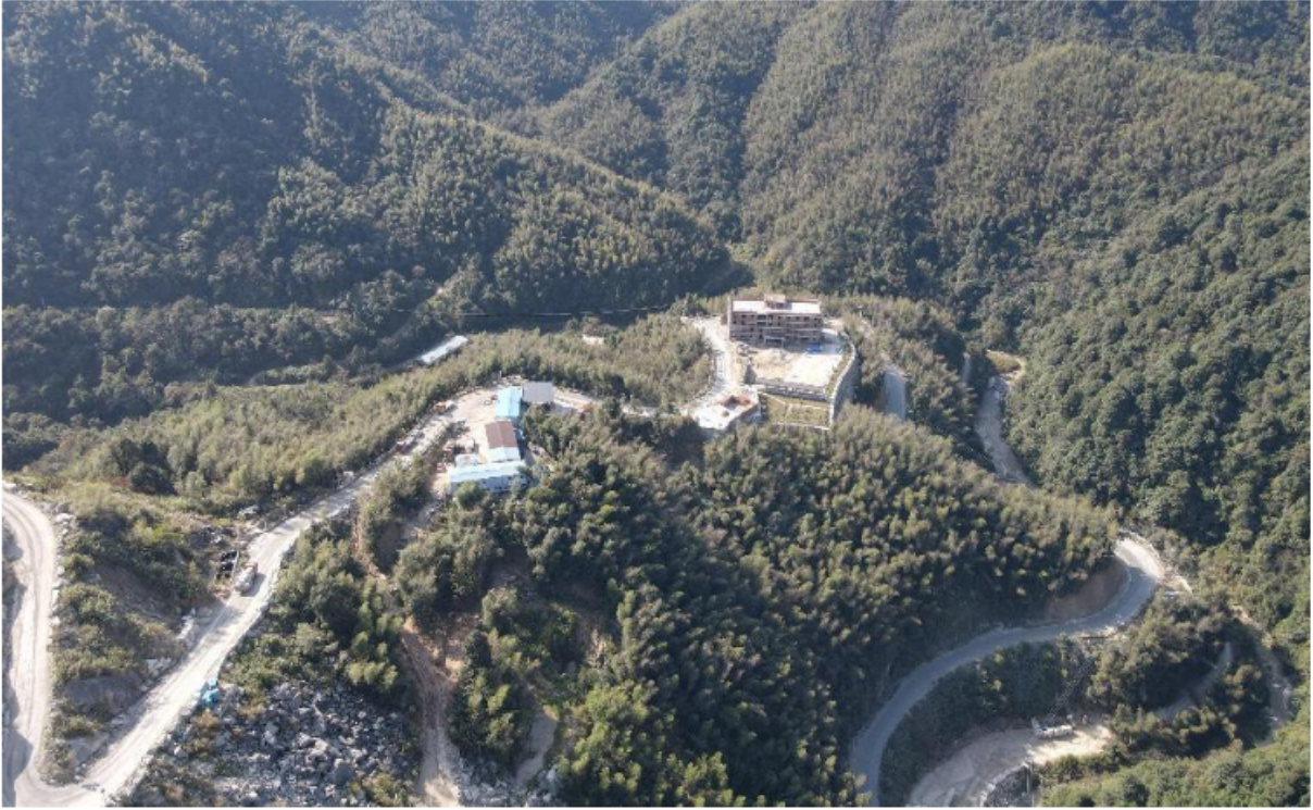
图 2-4 水泥硬化道路
