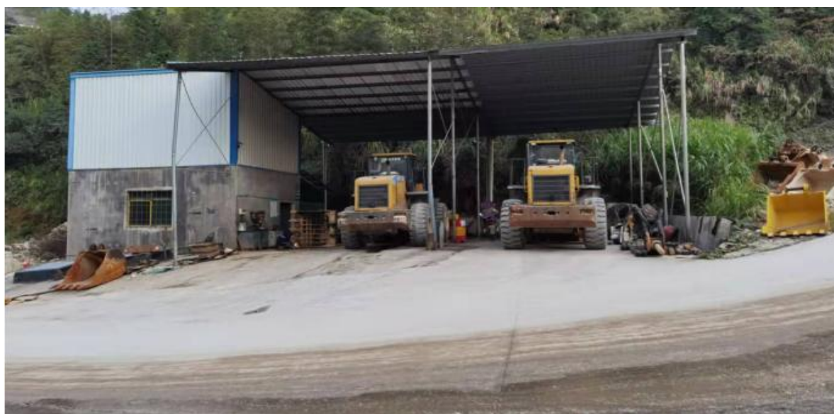
图 2-9 选矿厂机修车间
