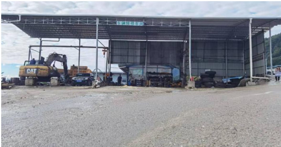
图 2-8 矿山维修车间
