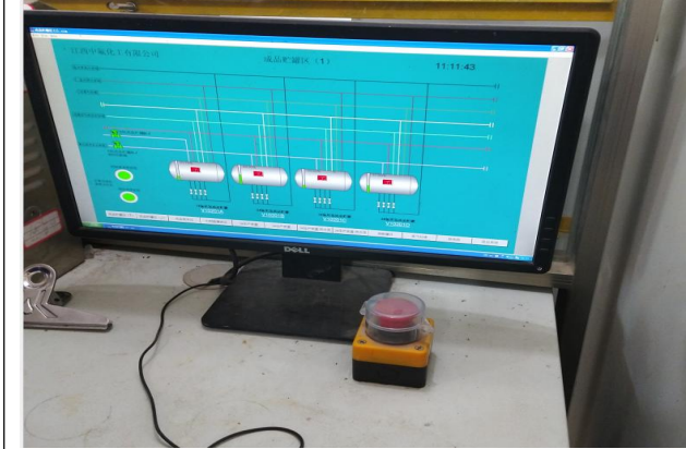
SIS 系统联锁界面及紧急停车按钮设置情况
