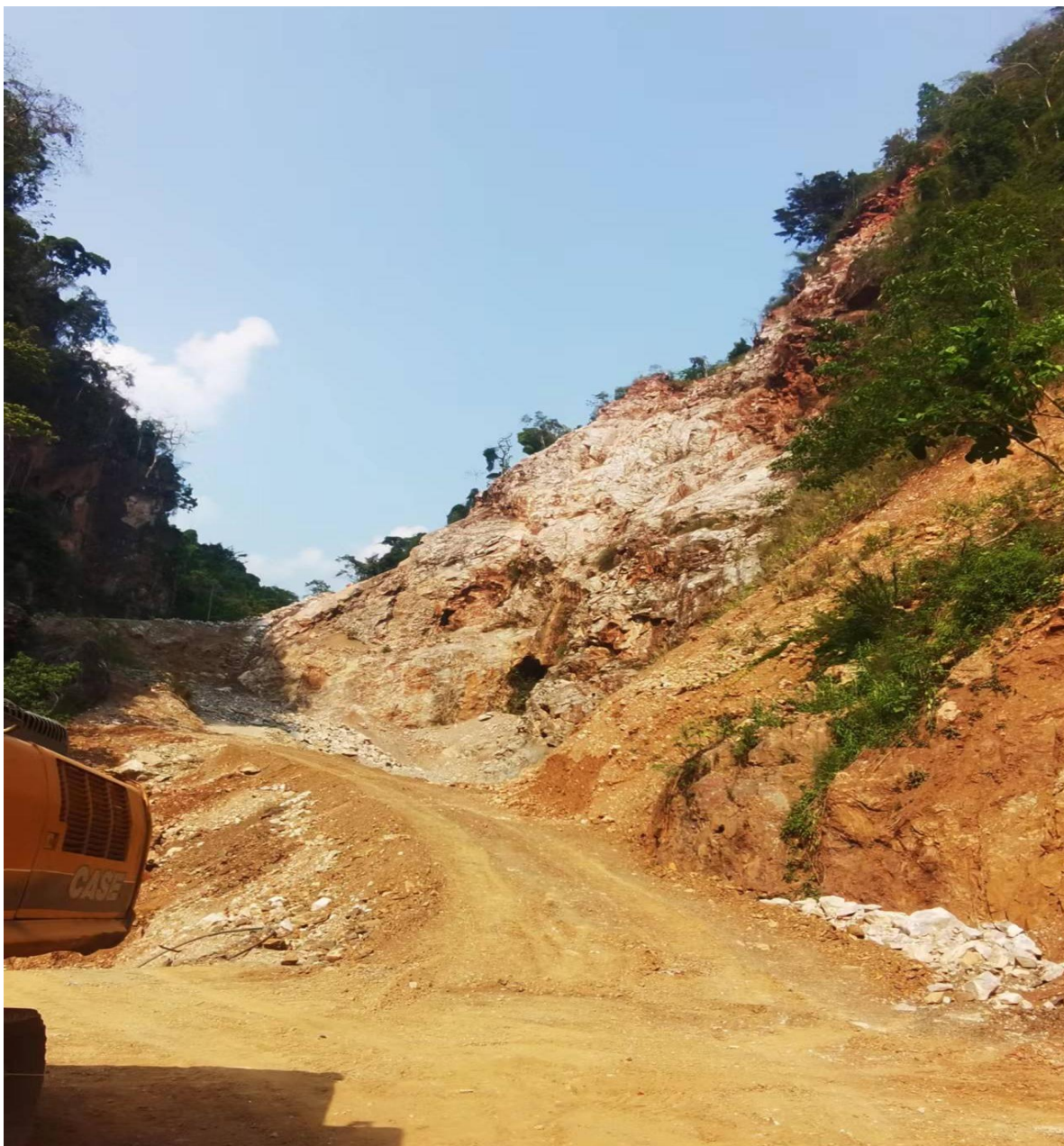
图 2.4-2 挖掘机上山道路及原有采空区
