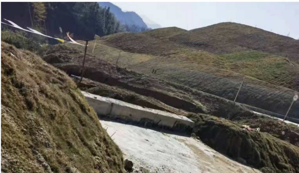
图 2-4 +238m 卸料平台
