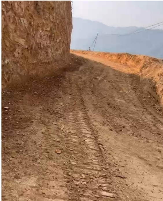
运输道路及车档设施
