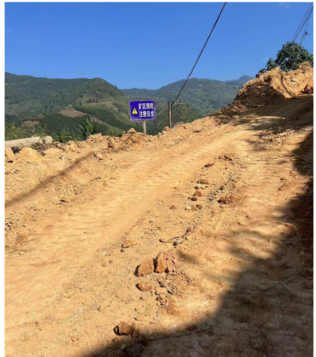
采场入口警示标志设置情况
