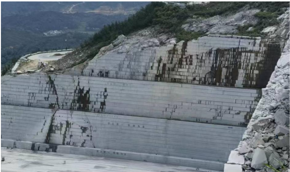
图 2-6 采场东侧边坡
