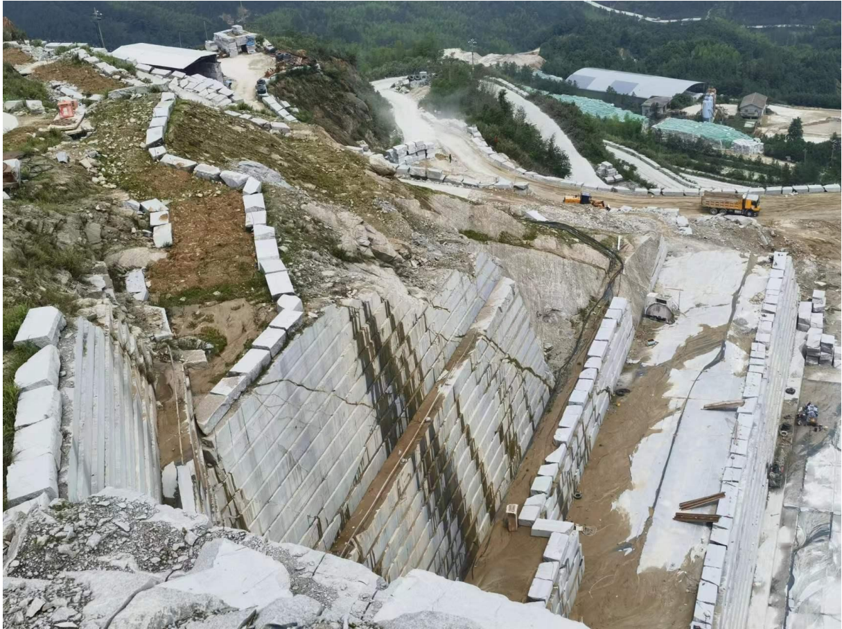
图 2-5 采场西侧边坡
