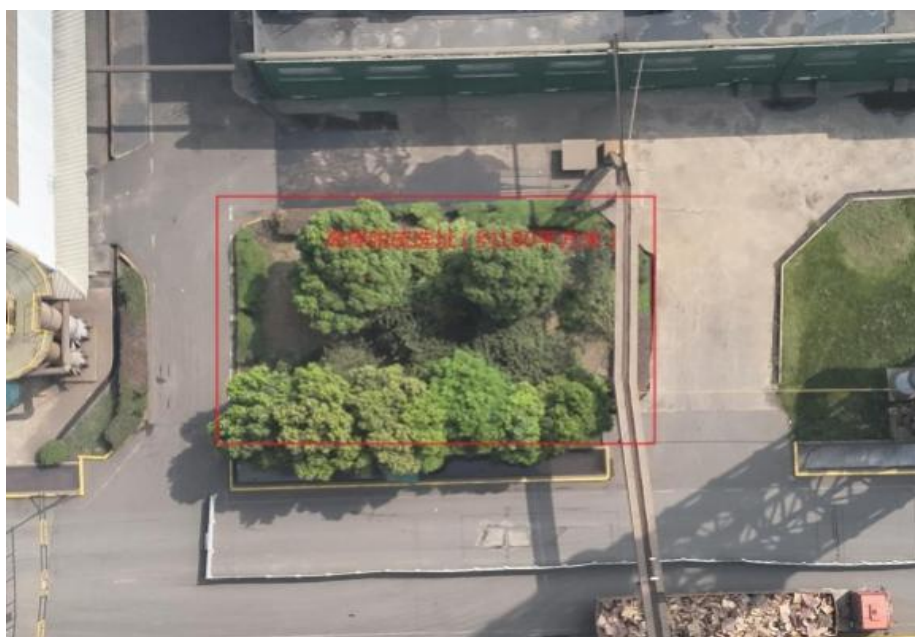
图 2.3-2 高棒车间烟气脱硫装置周边情况
