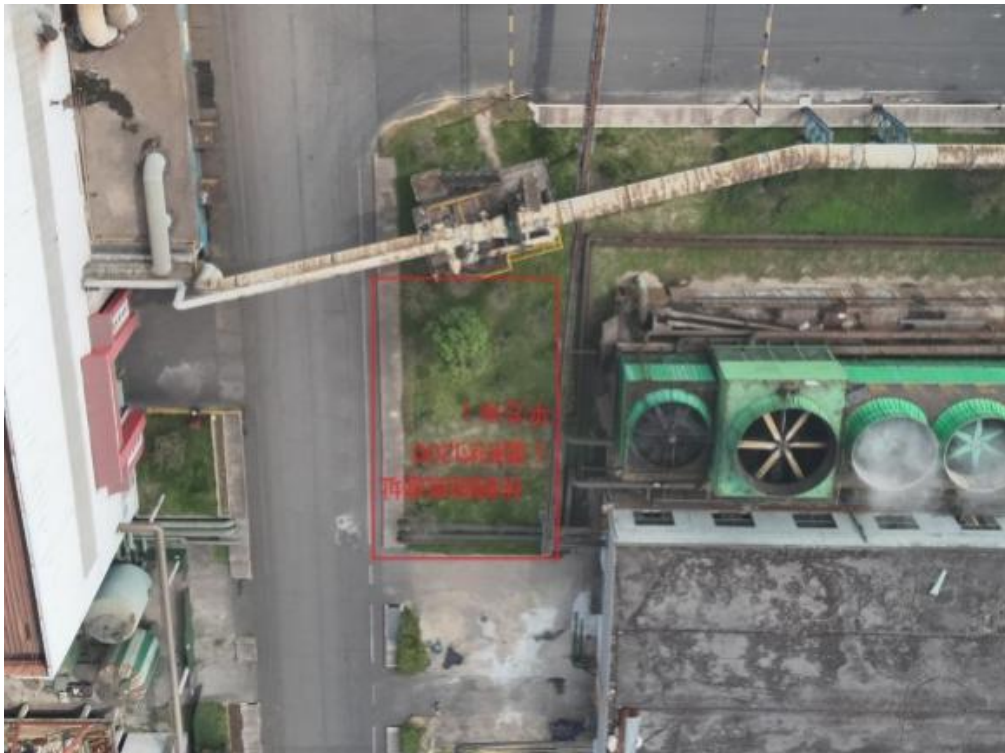
图 2.3-3 优钢线烟气脱硫装置周边情况
